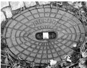
In unserem Beispiel befindet sich der Hydrant 0,3 Meter vor dem Schild und 6,3 Meter links davon. Den Hydranten an sich erkennt man an der ovalen Metallplatte mit der Aufschrift „HYDRANT“.
